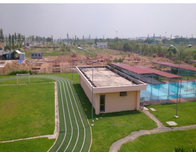
Hình ảnh công trình đang thi công
