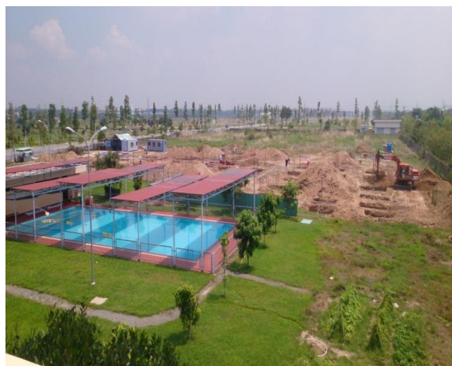
Hình ảnh công trình đang thi công
