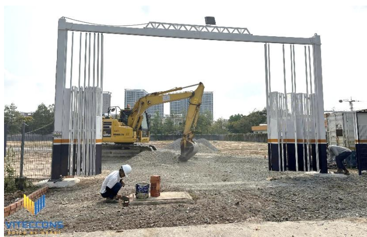
Phân cảnh các tòa nhà Giai đoạn 3 đang được triển khai triển khai tại trường Quốc Tế Singapore (SIS) Thành phố Mới Bình Dương.
